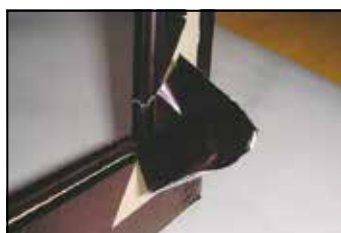
5. 側面を巻き込む様に貼付けます。
